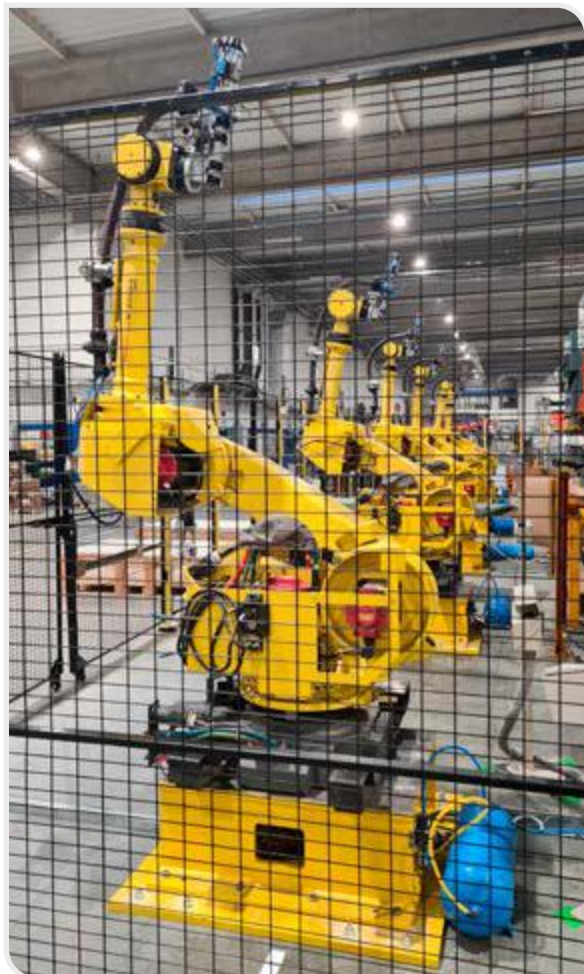
Fot. 2. // Roboty po ustawieniu i zakotwieniu
