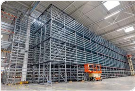
Fot. 1. // Konieczna przestrzeń wolna w magazynie podczas prac montażowych (źródło: materiały własne LLS)
