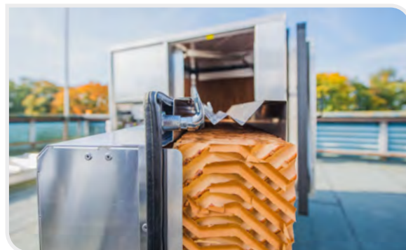
Fot. 1. // Złożo desorpcyjne w jednostkach CoolStream® ma 15 cm grubości i jest nawilżane wodą wodociągową
